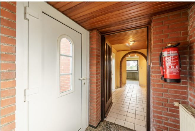
Blick vom Windfang in den Flur
