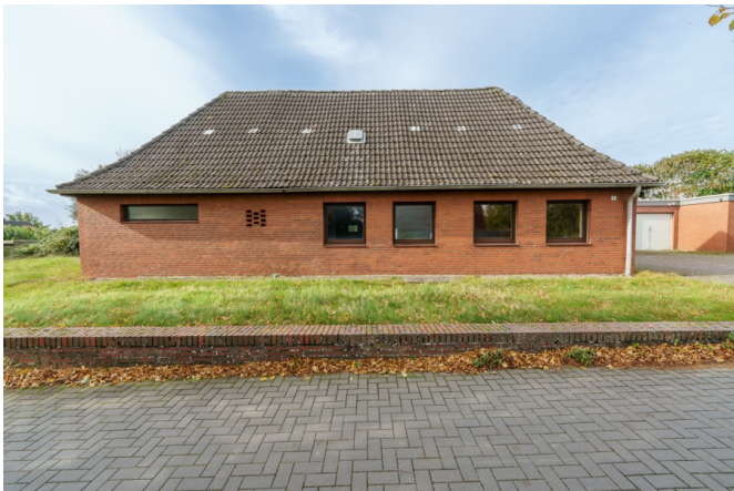
Hausansicht von der Eutiner Landstraße
