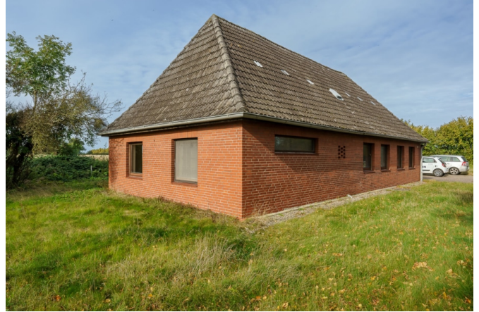
Hausansicht von der Eutiner Landstraße
