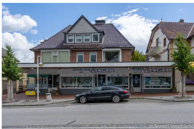
Hausansicht von der Bahnhofstraße
