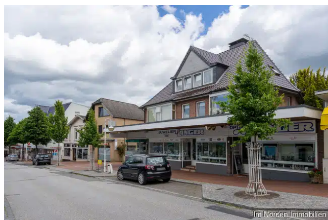
Hausansicht von der Bahnhofstraße
