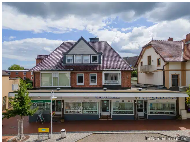
Hausansicht von der Bahnhofstraße
