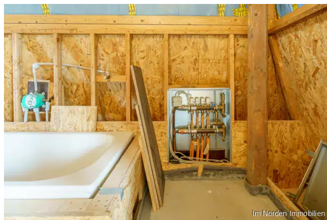
Teilausgebautes Dachgeschoss, Vorbereitung Fußbodenheizung
