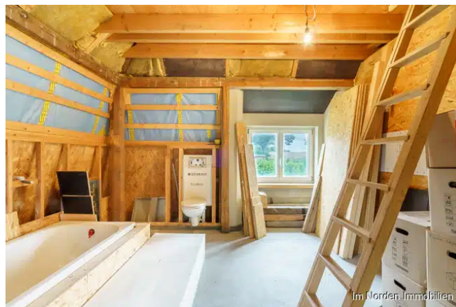
Teilausgebautes Dachgeschoss, Vorbereitung Badezimmer
