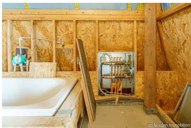
Teilausgebautes Dachgeschoss, Vorbereitung Fußbodenheizung
