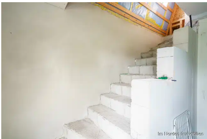
Treppe ins Dachgeschoss
