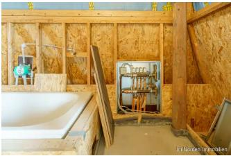
Teilausgebautes Dachgeschoss, Vorbereitung Fußbodenheizung
