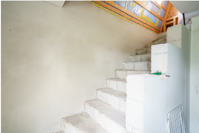
Treppe ins Dachgeschoss
