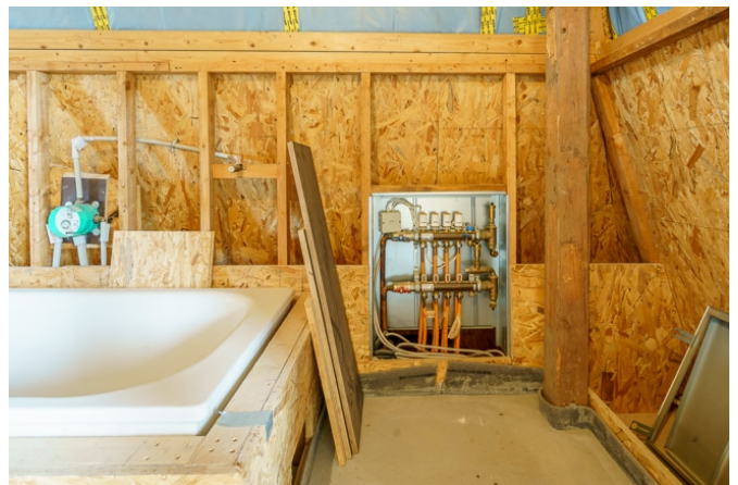
Teilausgebautes Dachgeschoss, Vorbereitung Fußbodenheizung
