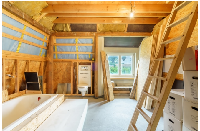
Teilausgebautes Dachgeschoss, Vorbereitung Badezimmer
