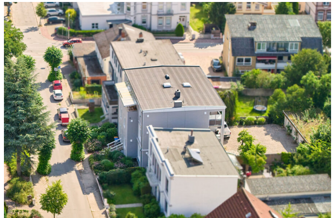
Seitliche Grundstücksansicht von oben
