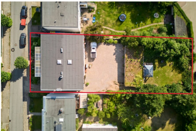
Grundstücksansicht von oben
