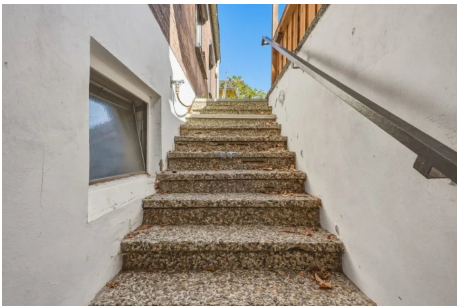
Treppe zum Kellergeschoss
