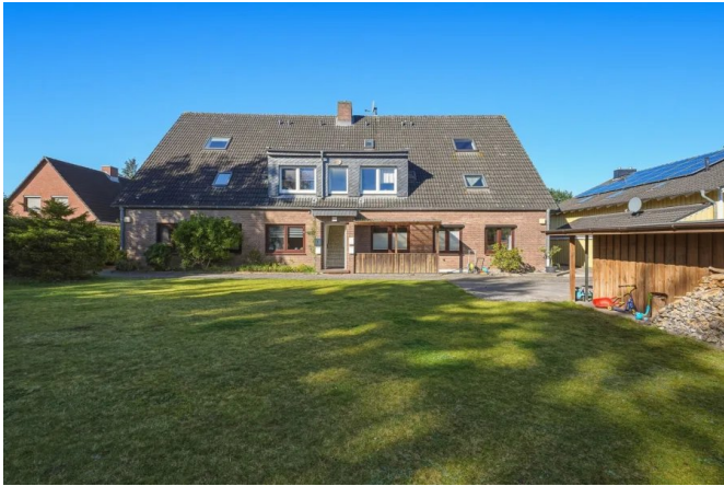
Blick auf das Mehrfamilienhaus von der Rückseite, Zugang zum Dachgeschoss
