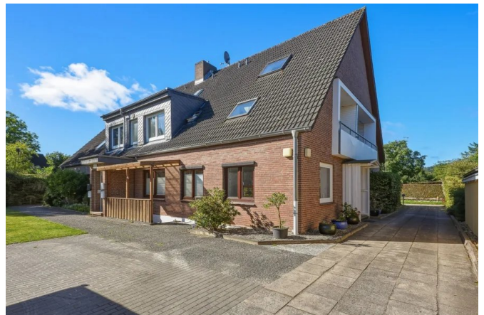
Blick auf den Eingang zur Erdgeschosswohnung Nr. 2
