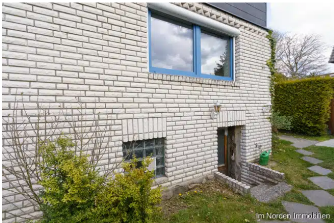
Zuwegung zu dem separaten Hauseingang und zum Garten
