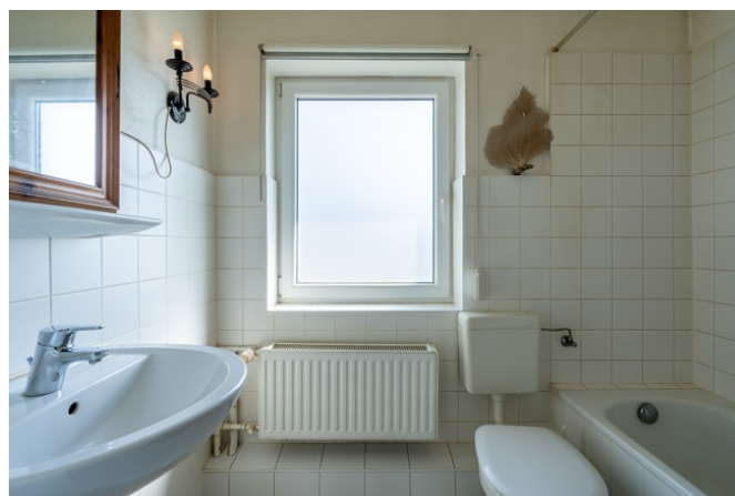
Badezimmer im Obergeschoss
