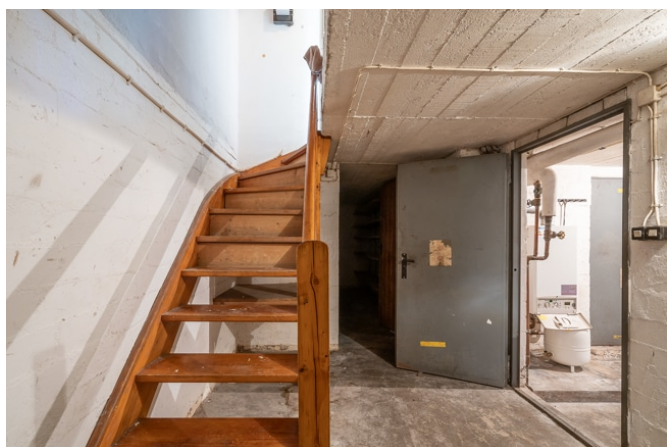
Treppe ins Kellergeschoss
