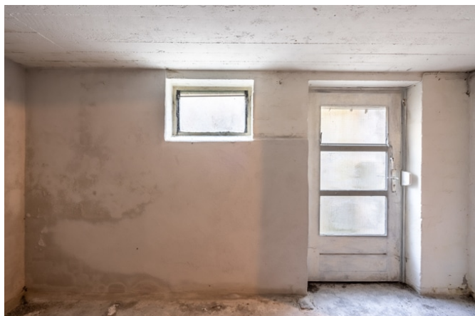
Hausnebeneingang im Kellergeschoss
