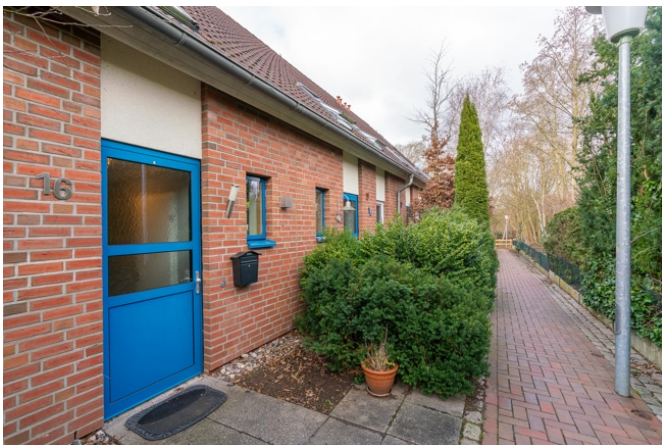
Blick auf den Hauseingang
