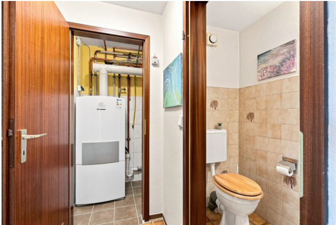
Heizungsraum und separates WC
