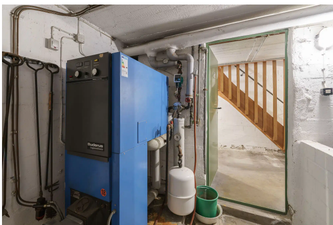
Öl-Heizungsanlage von 1978
