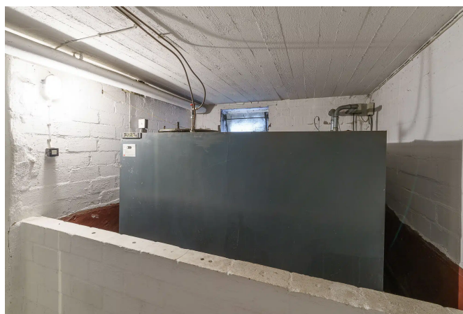
Öltank im Kellergeschoss
