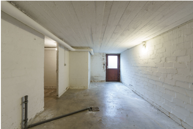
Blick auf den Hausnebeneingang im Kellergeschoss
