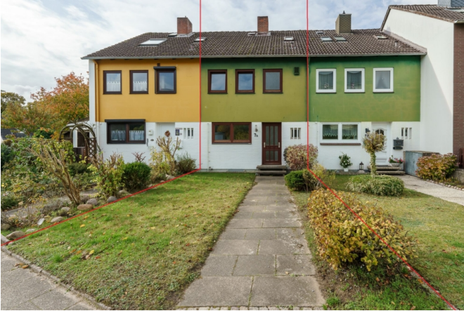
Hausansicht von der Polziner Straße
