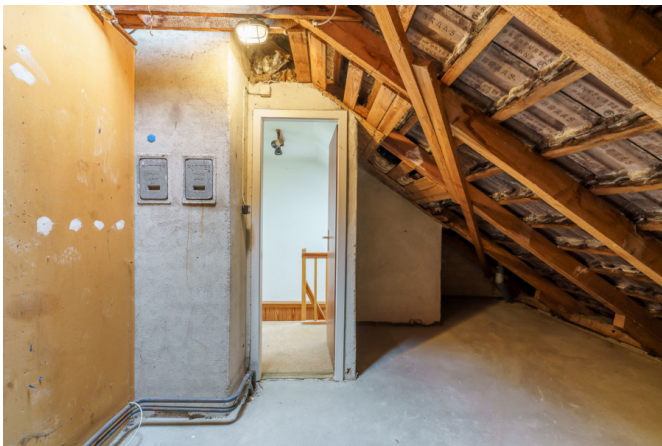
Bodenraum im Dachgeschoss
