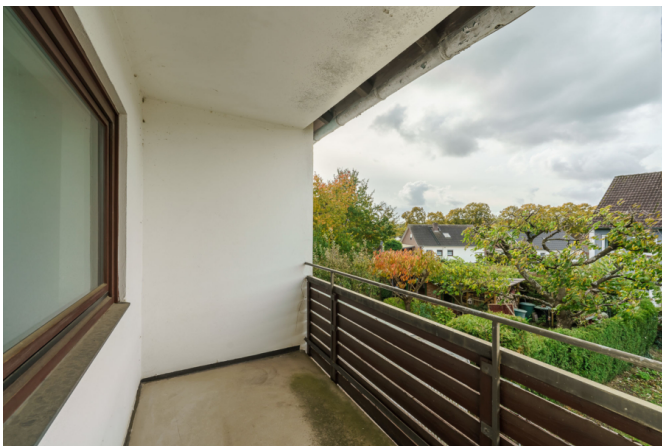
Balkon im Obergeschoss
