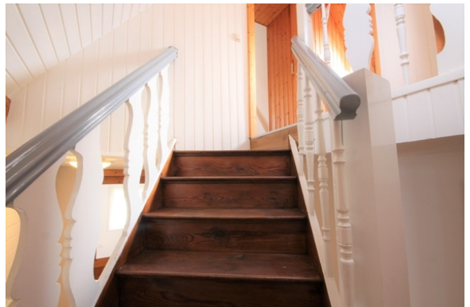
Treppe in dem Spitzboden
