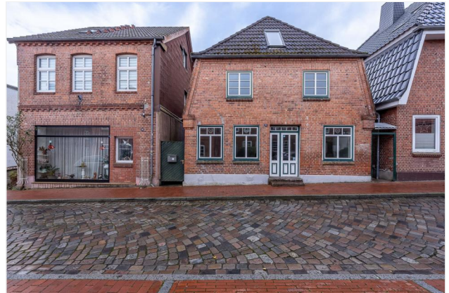
Blick von der Neuwerkstraße
