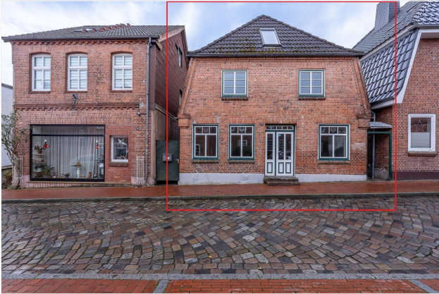
Blick von der Neuwerkstraße
