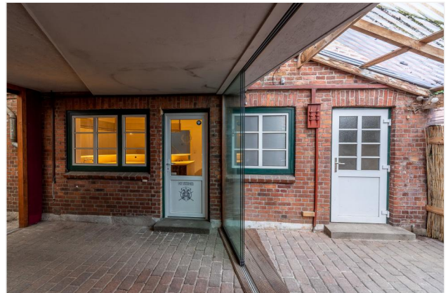
Überdachter Durchgang zum Hofgebäude
