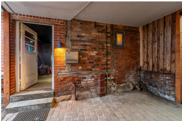
Überdachter Durchgang zum Hofgebäude
