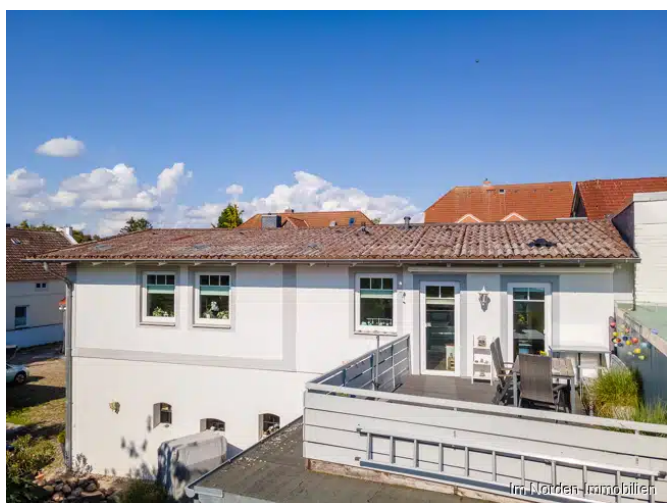
Blick auf die Dachterrasse
