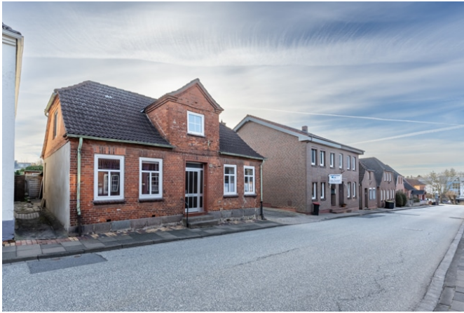
Blick in die Hospitalstraße
