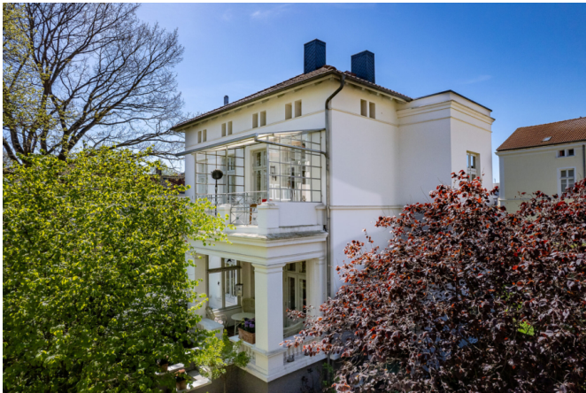
Ansicht von der Stresemannstraße
