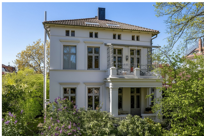
Ansicht von der Stresemannstraße
