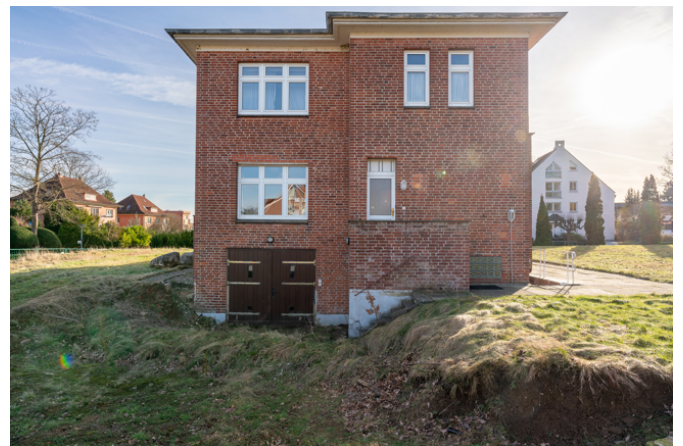
hintere Ansicht, Garage
