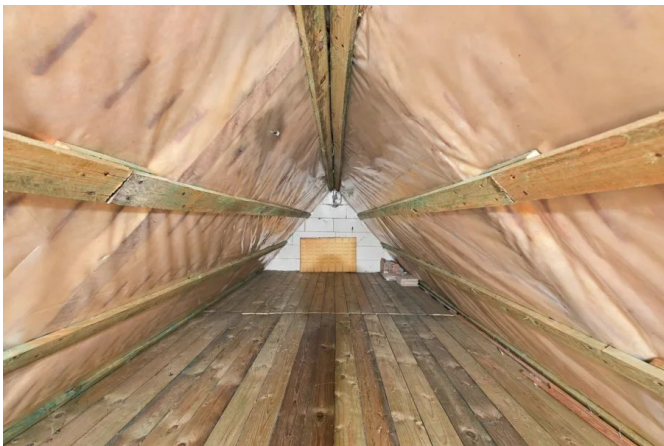
Spitzboden zum Abstellen
