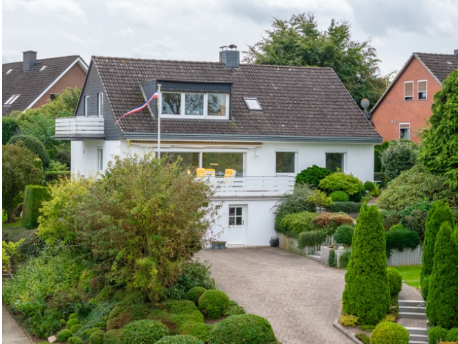
Ansicht von der Zufahrt
