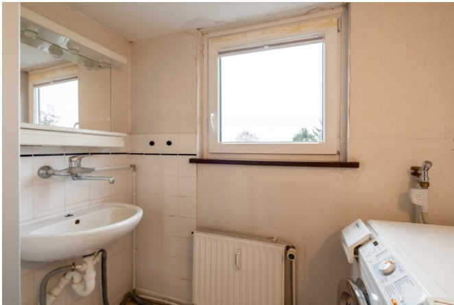
Duschbad im Dachgeschoss
