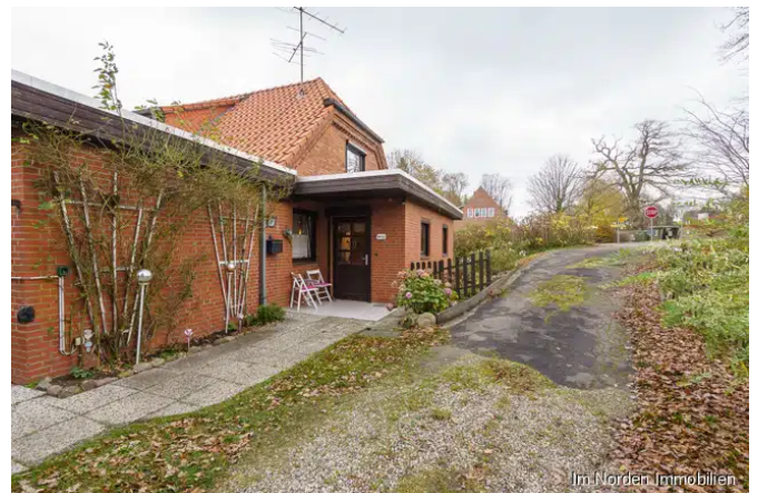
Blick auf den Hauseingang
