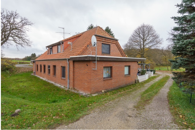
Hausansicht von der Straße
