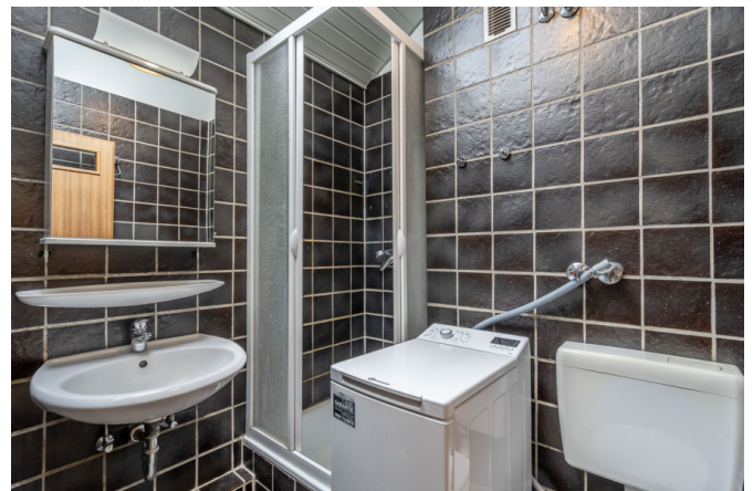
Duschbad mit Dachfenster wird aktuell renoviert
