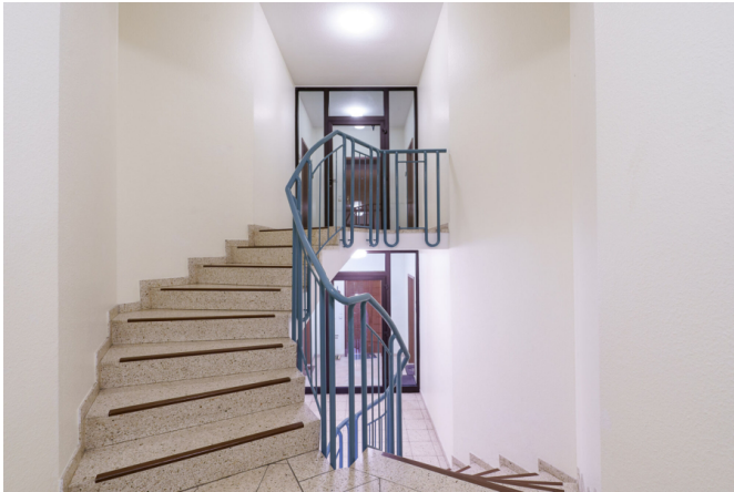
Treppenhaus, Zugang zum Kellergeschoss
