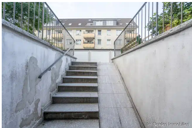
Nebeneingang zum Kellergeschoss
