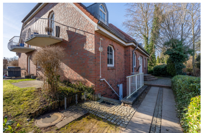
Zugang zum Mehrfamilienhaus
