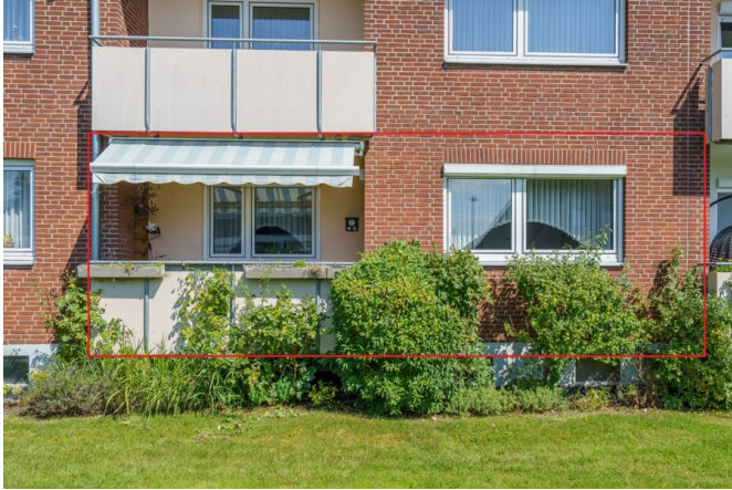
Blick auf die Wohnung mit Loggia
