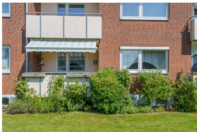
Blick auf die Wohnung mit Loggia
