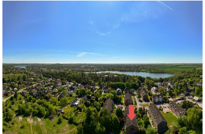
Lage des Mehrfamilienhauses
