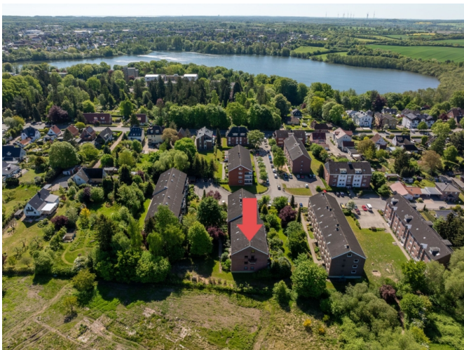
Lage des Mehrfamilienhauses
