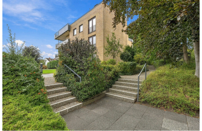
Gepflegte Aussenanlage, Zuwegung zum Haus
