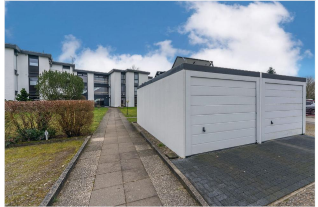
Garage mit Weg zum Haus
