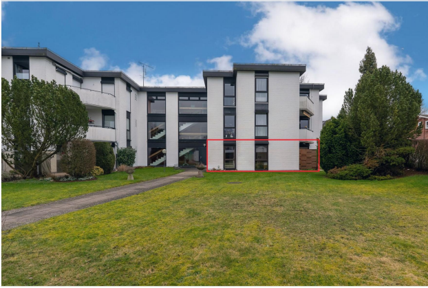
Gebäude von der Gartenseite
