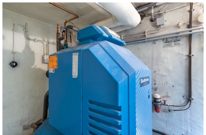
Öl-Heizungsanlage
