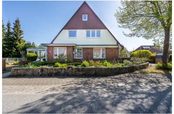
Hausansicht von der Straße
