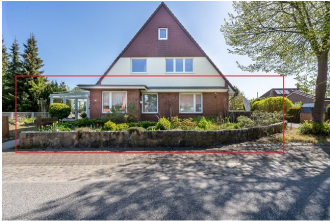
Hausansicht von der Straße
