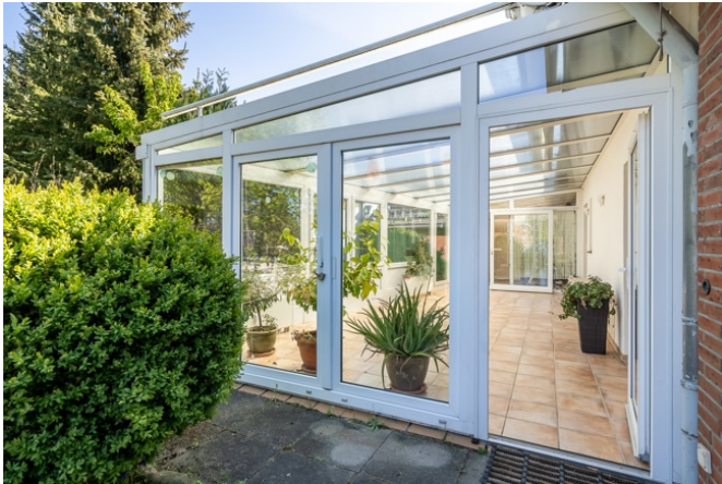
Wohnungseingang über den Wintergarten
