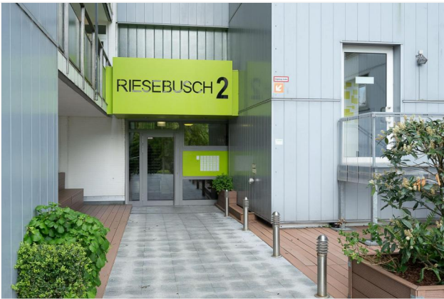
Blick auf den Hauseingang
