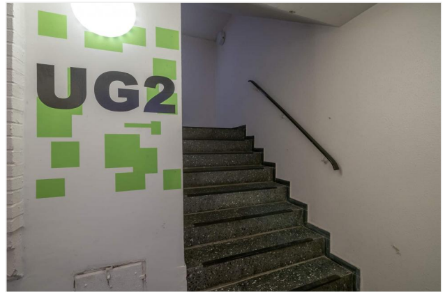
Treppe zum Kellergeschoss
