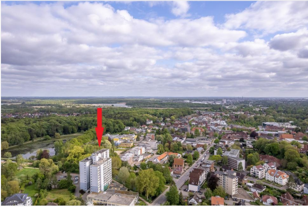
Gebäudeansicht von oben
