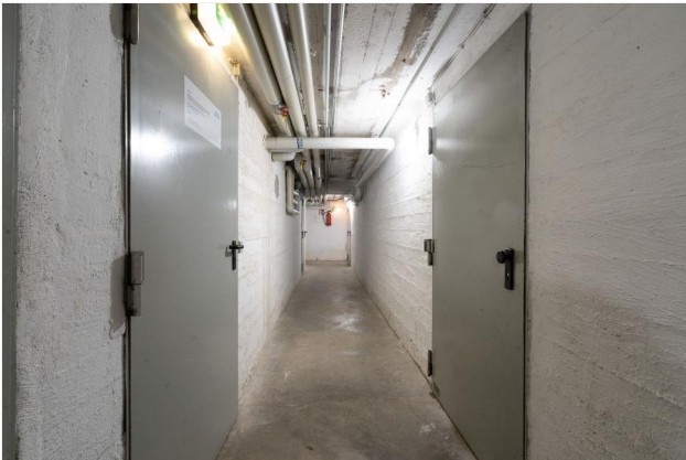
Flurbereich im Kellergeschoss
