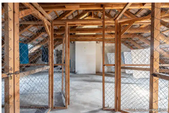
Blick auf den Dachboden
