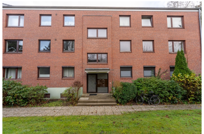
Blick auf den Hauseingang
