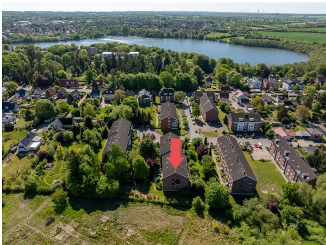
Blick auf das Mehrfamilienhaus und den Kleinen Eutiner See
