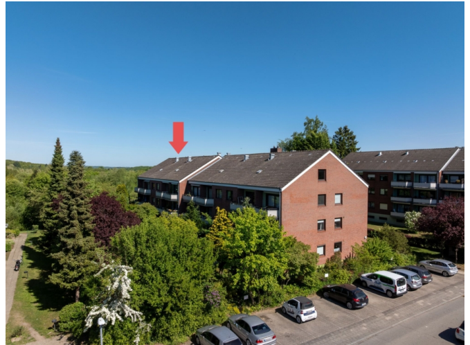
Blick auf das Mehrfamilienhaus
