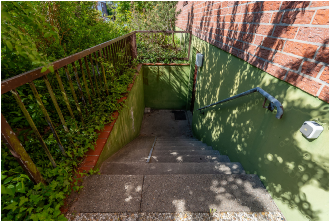
Zugang in den Fahrradkeller
