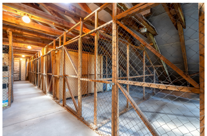
Abstellkammern im Dachgeschoss
