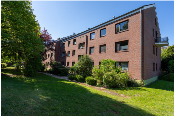
Blick auf das Mehrfamilienhaus
