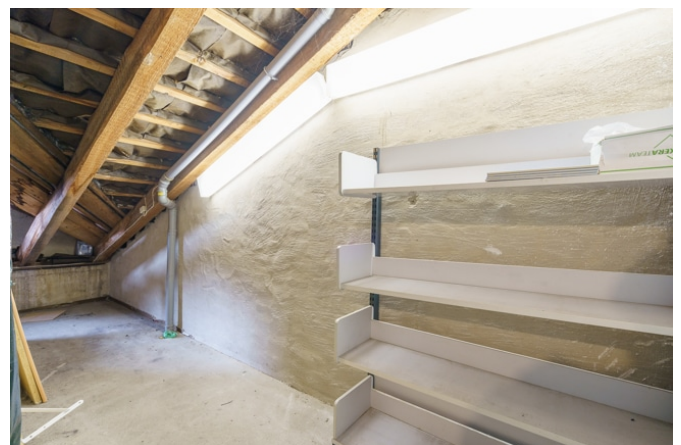
Abstellraum auf dem Dachboden
