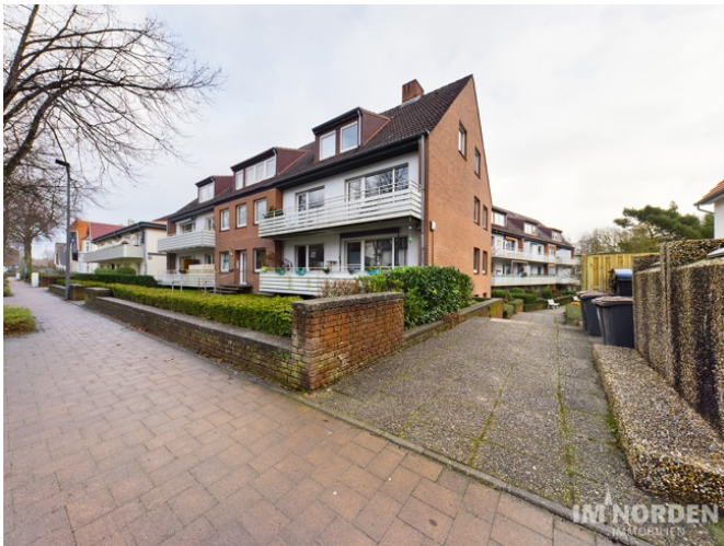
Ansicht von der Riemannstraße
