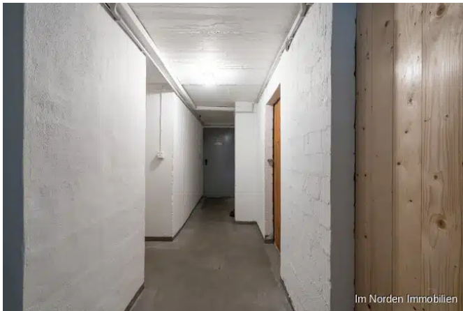
Flurbereich im Keller
