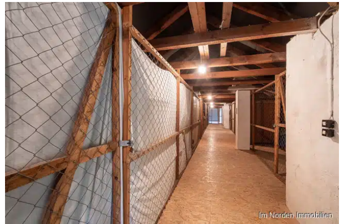
Blick auf den Dachboden
