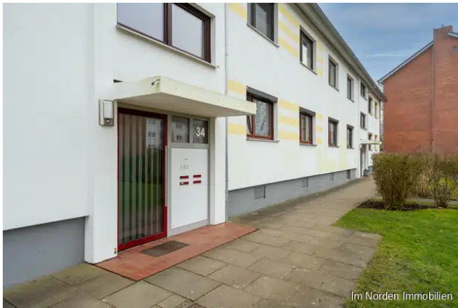
Blick auf den Hauseingang
