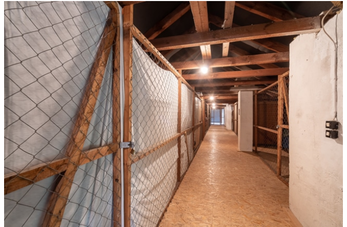
Blick auf den Dachboden
