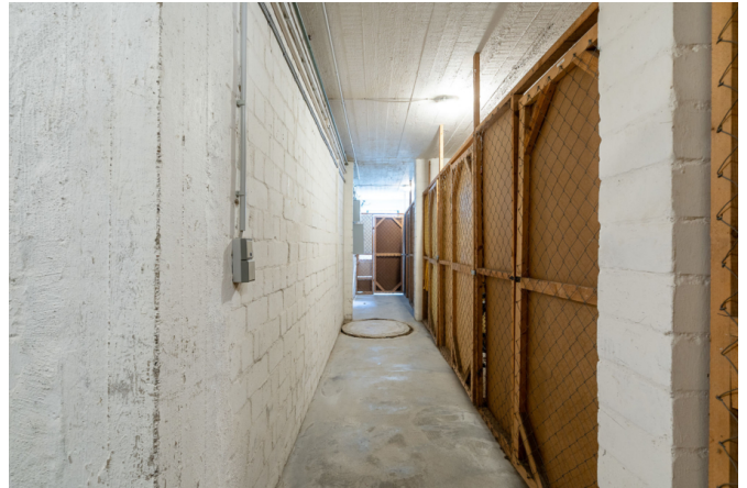
Untergeschoss mit Kellerräumen
