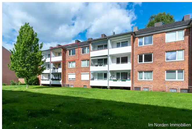
Blick auf die Eigentumswohnung
