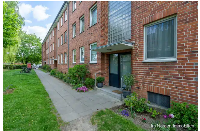
Blick auf den Hauseingang
