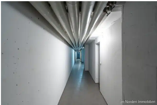
Zugang zur Tiefgarage
