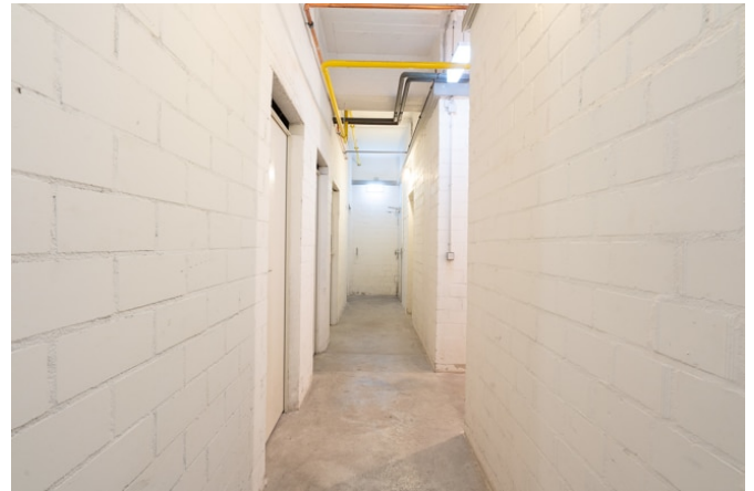
Zugang zum Keller
