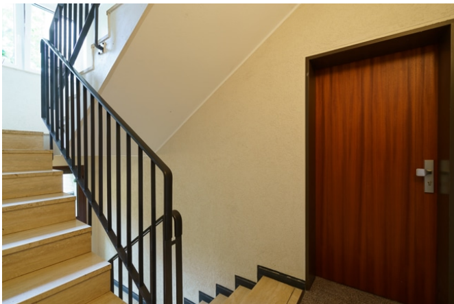
Blick auf die Wohnungstür
