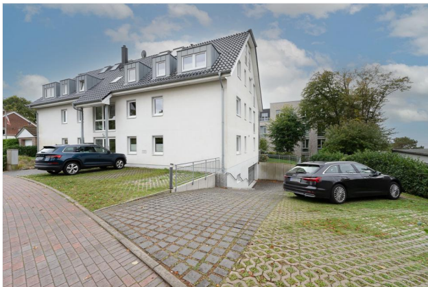
Hausansicht von der Pelzerhakener Straße
