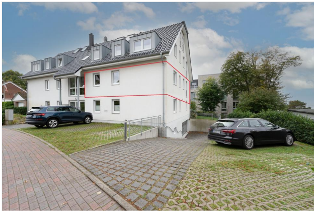
Hausansicht von der Pelzerhakener Straße
