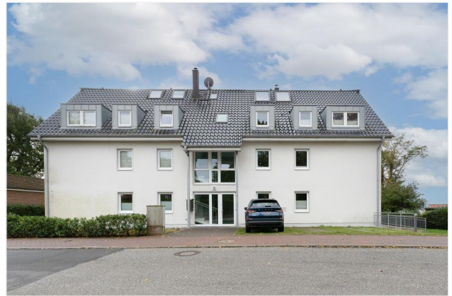
Hausansicht von der Pelzerhakener Straße
