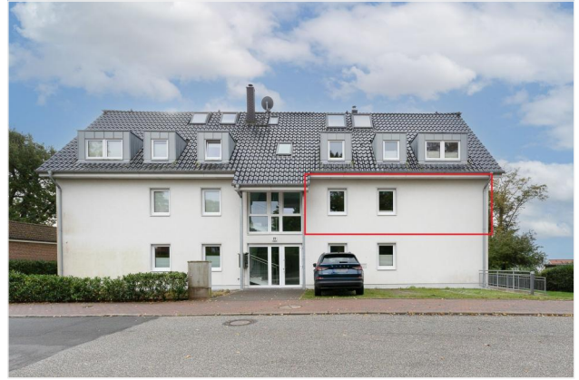
Hausansicht von der Pelzerhakener Straße
