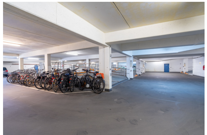
Fahrradabstellmöglichkeiten in der Tiefgarage
