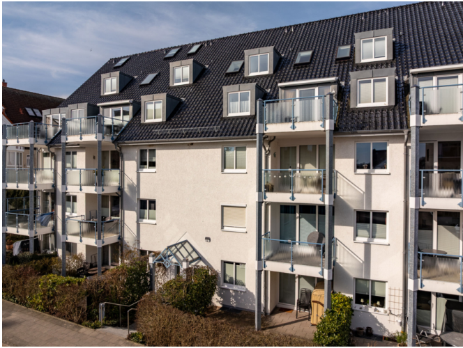
Blick auf den Hauseingang
