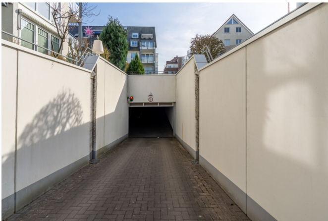
Zufahrt in die Tiefgarage
