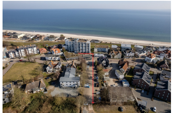
Weg zum PKW-Außenstellplatz
