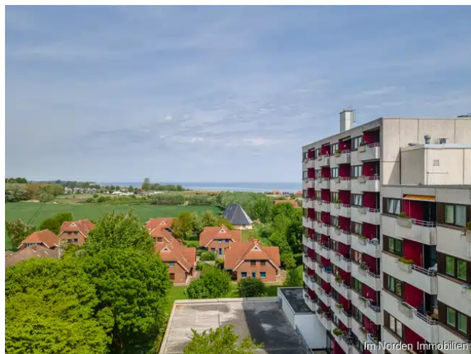
Haus Berolina -Blick zur Ostsee
