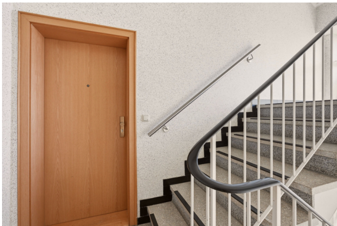
Treppe in das Dachgeschoss
