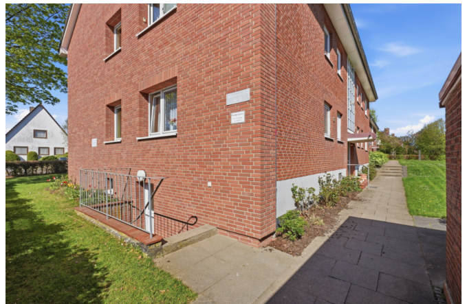
Zugang zum Hauseingang
