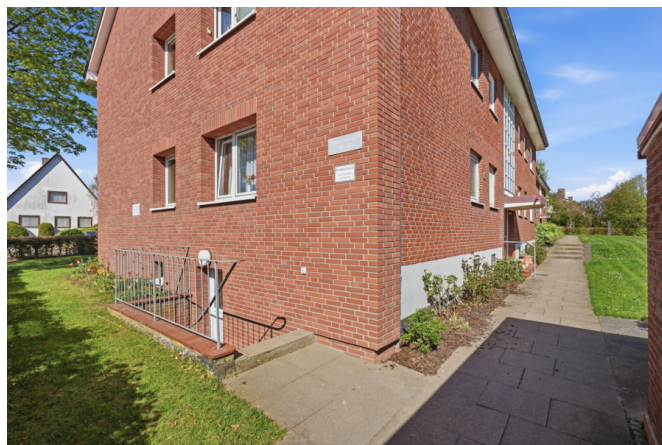
Zugang zum Hauseingang
